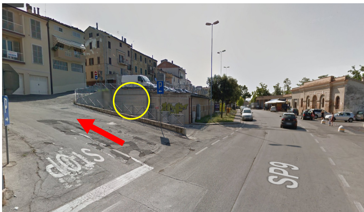
Strada di accesso al lastricato solare (parcheggio pubblico) ed accesso principale all'immobile
