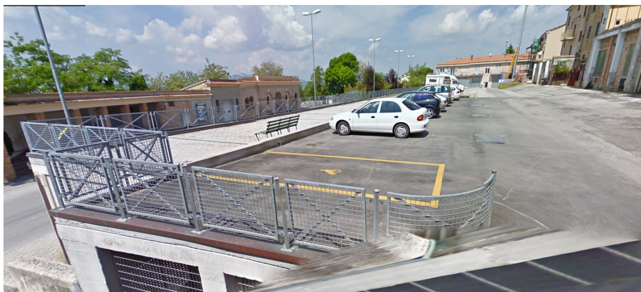
Lastricato solare (copertura autorimessa)
