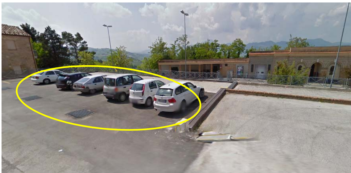
Lastricato solare: visibile la divisione tra la parte esistente e la parte di nuova costruzione oggetto di stima (area cerchiata)
