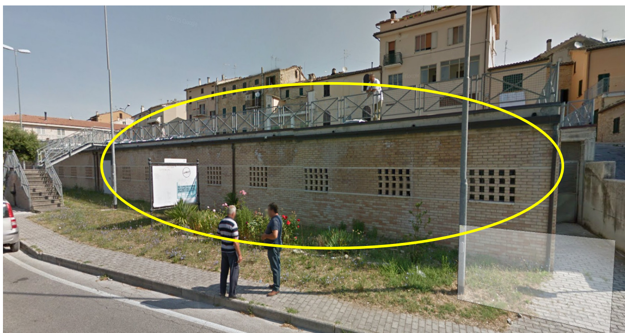
Prospetto su Via De Gasperi (evidenziato parte dell'immobile oggetto di stima)
