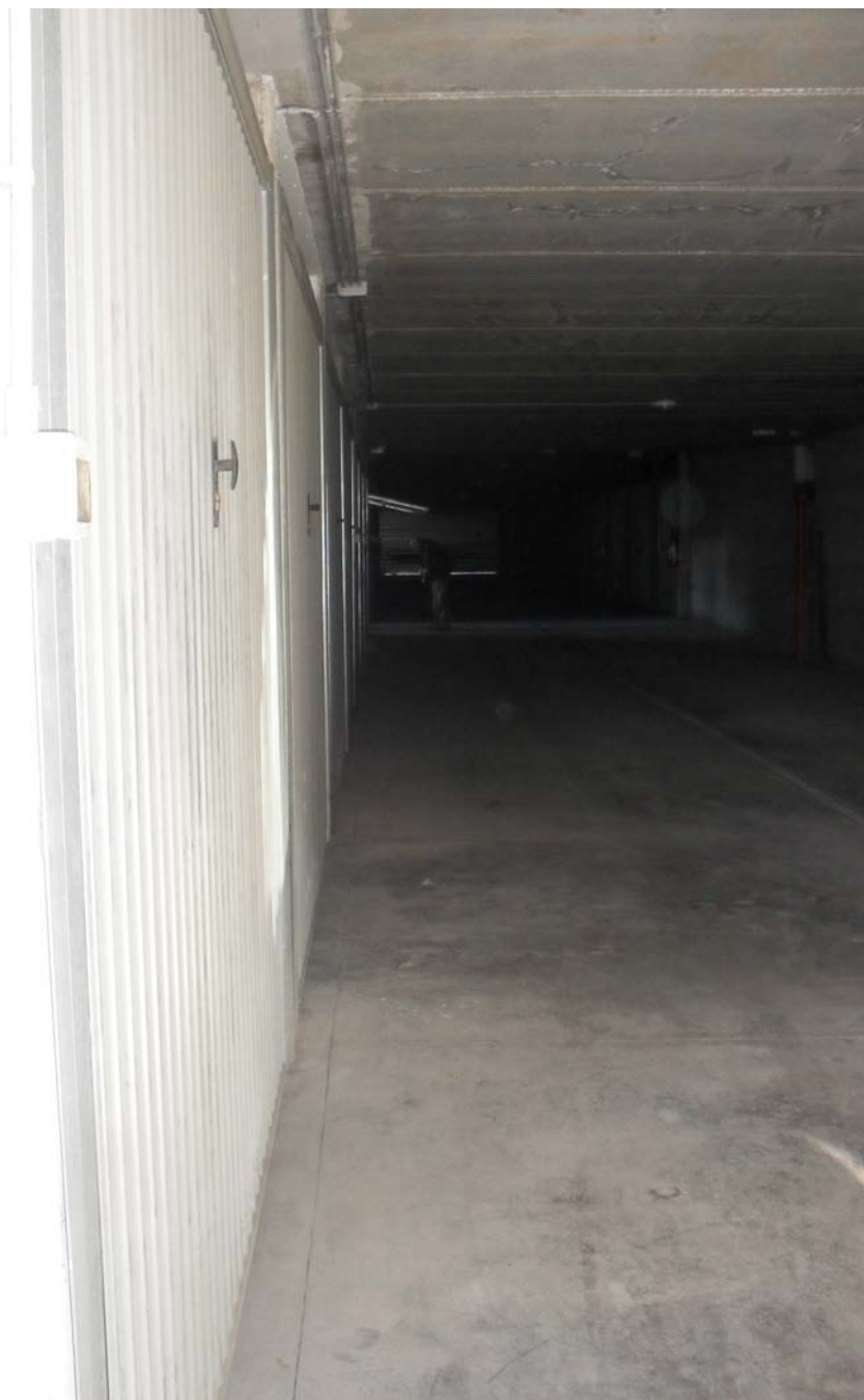
Vista interna dell'autorimessa (rivolto verso l'ingresso)
