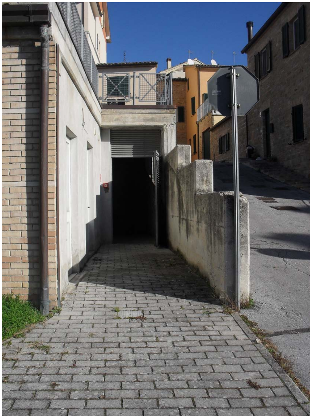
Particolare dell'uscita di emergenza e dell'accesso al lastricato solare
