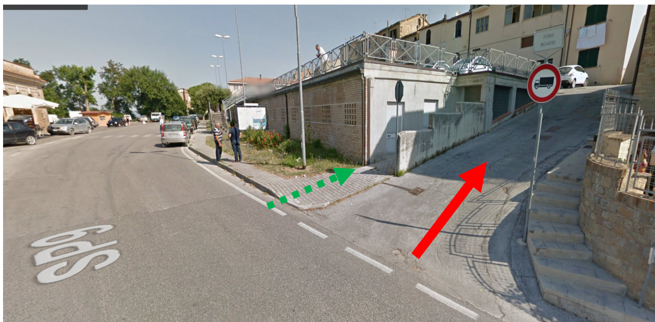
Strada di accesso al lastricato solare (linea rossa) ed uscita di sicurezza (linea verde)
