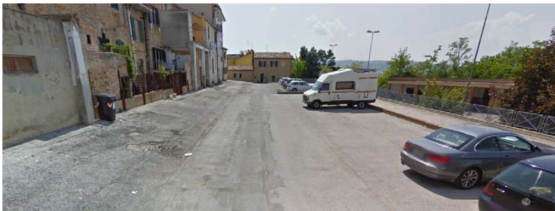
Lastricato solare (copertura autorimessa)
